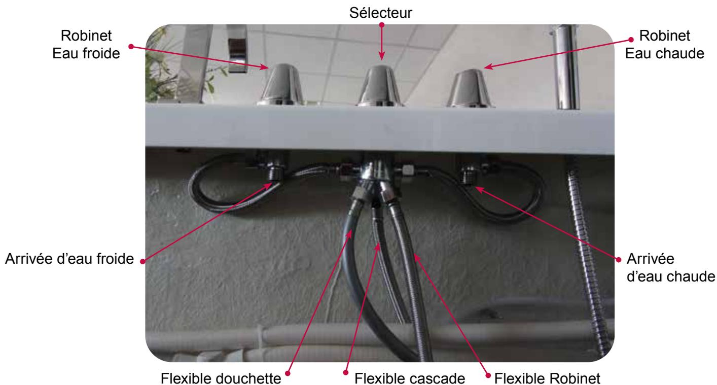
**Les flexibles fournis, prévus pour le raccordement des accessoires**, sont déjà pré-montés sur la baignoire. Il vous faudra brancher chaque flexible au bon accessoire en fonction du pictogramme dessiné sur le sélecteur : la douche, la cascade, ou le robinet de service dauphin.
