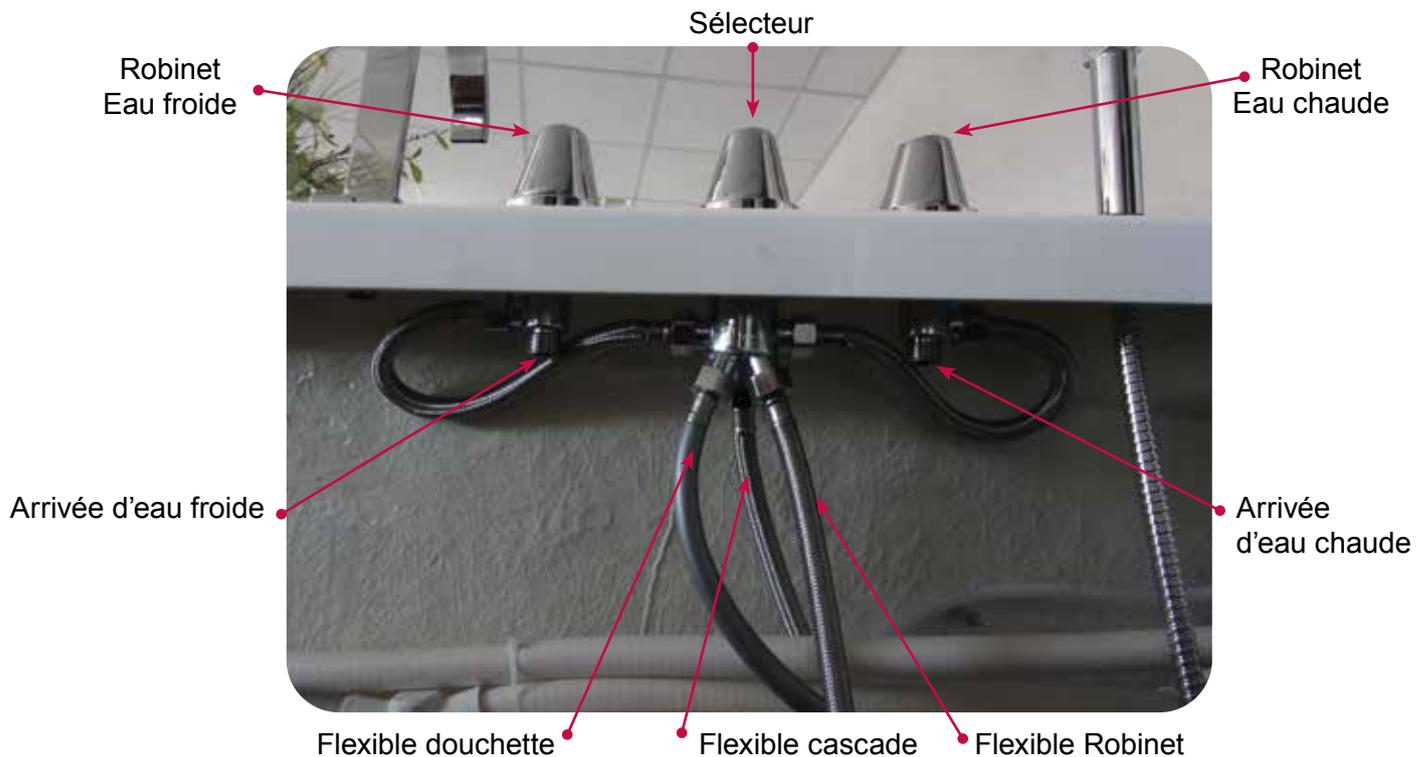
**Les flexibles fournis, prévus pour le raccordement des accessoires**, sont déjà pré-montés sur la baignoire. Il vous faudra brancher chaque flexible au bon accessoire en fonction du pictogramme dessiné sur le sélecteur : la douche, la cascade, ou le robinet de service dauphin.
